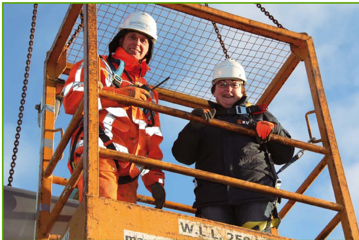
15 december 2010 - gedeputeerde Tineke Schokker (rechts) plaatst de laatste twee torentjes op het hoogste punt van het nieuwe provinciehuis.
